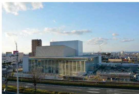
完成間近のしこちゅ〜ホール
