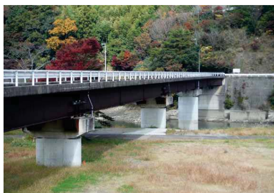
橋りょう耐震工事を行っている瀬川橋（富郷町）
