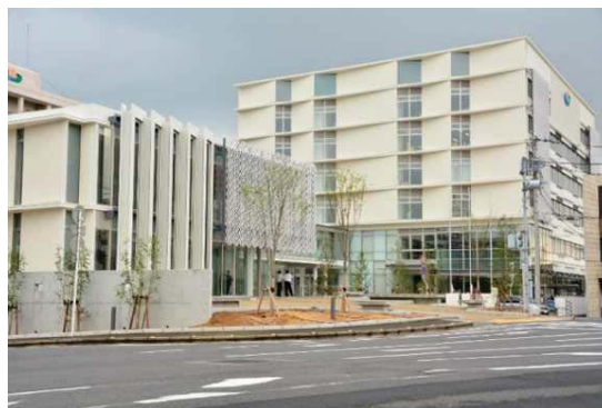
平成30年9月に開庁した新庁舎
