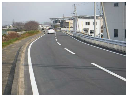
舗装修繕工事を行っている海通橋長原線（土居町）
