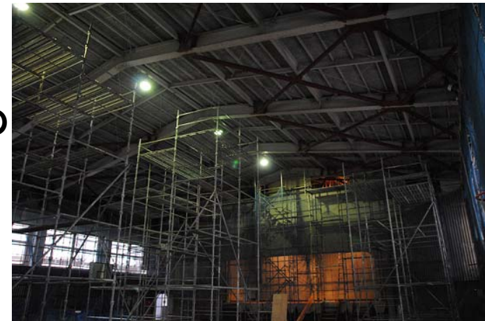
中曽根小学校屋内運動場耐震化工事
