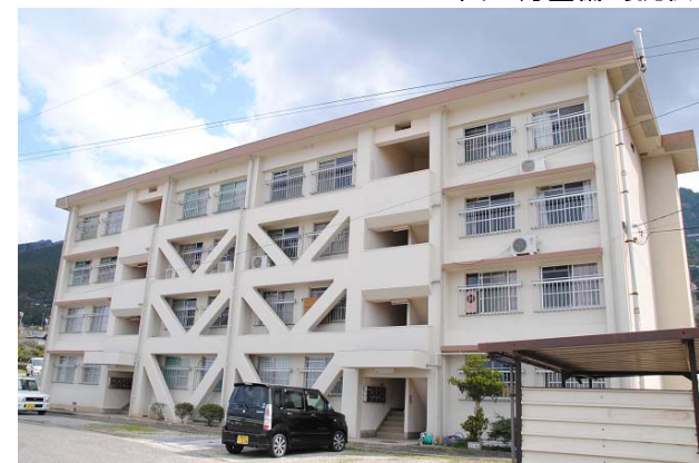
山田団地耐震化工事
