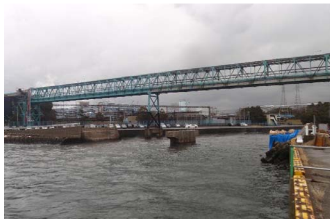
古い橋を撤去
