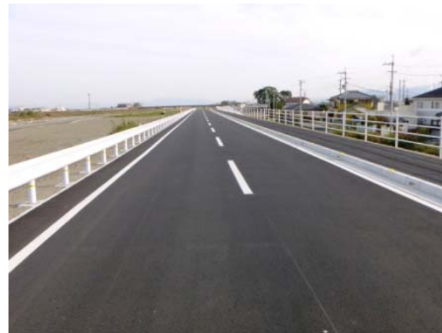
下井手藤原海岸線道路改良
