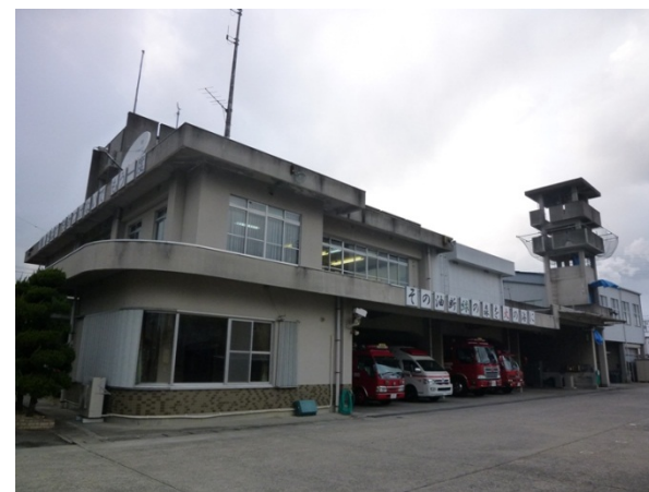
現在の消防本部（昭和50年建設）
