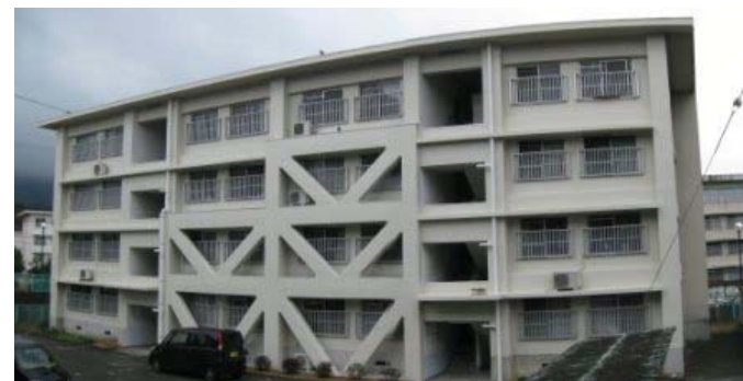
南部第1団地耐震化工事
