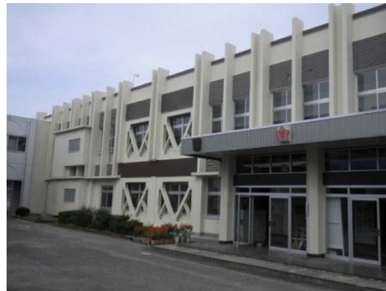
北小学校校舎耐震化工事
