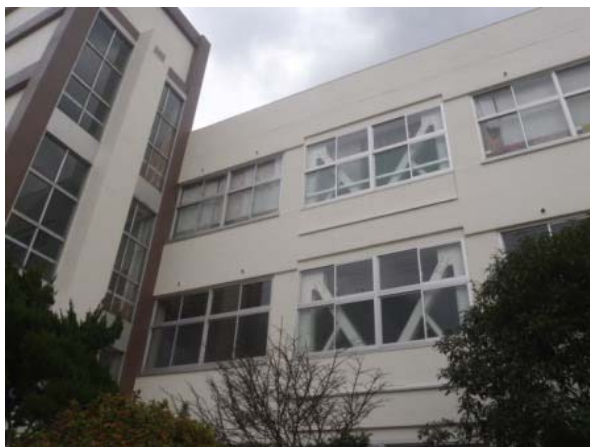
川之江南中学校校舎耐震化工事
