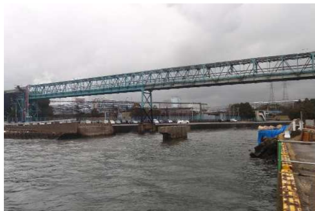
古い橋を撤去
