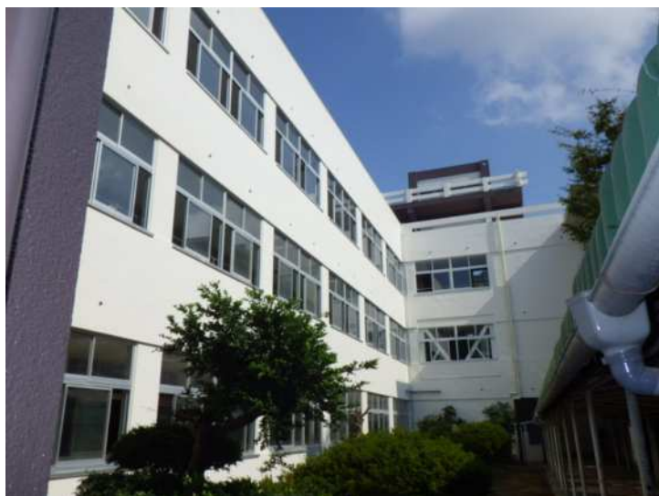
川之江北中学校校舎耐震化工事
