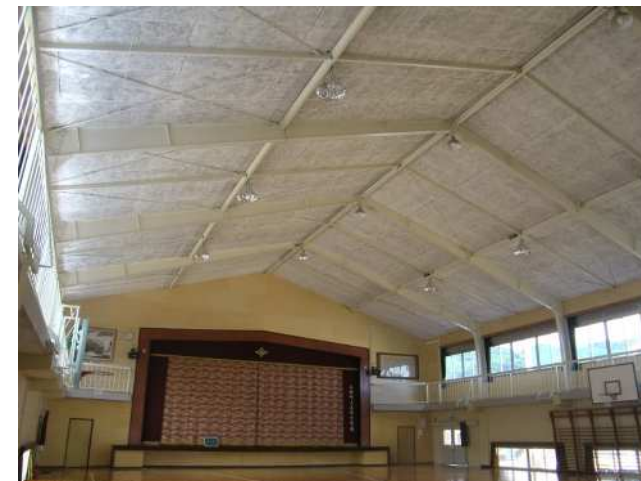
土居小学校屋内運動場耐震化工事
