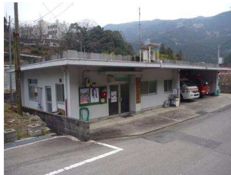
現在の新宮分遣所（昭和49年建設）
