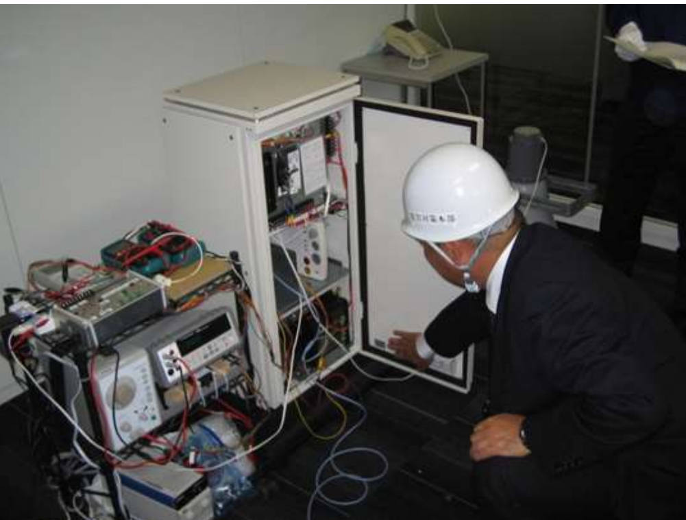
屋外スピーカーの放送設備
