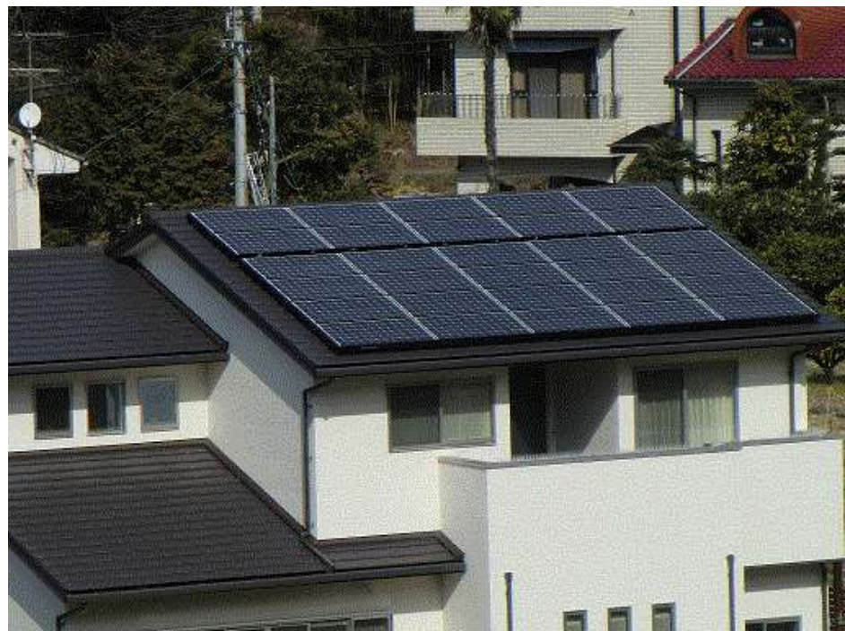
太陽光発電施設
