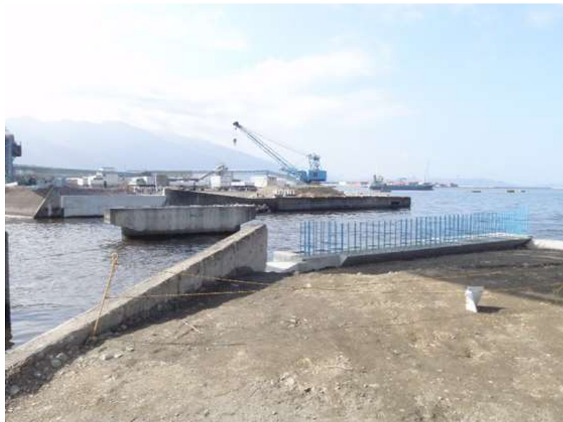
港橋橋梁改修
