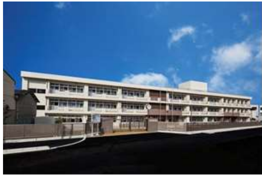
改築工事が完了した松柏小学校南校舎
