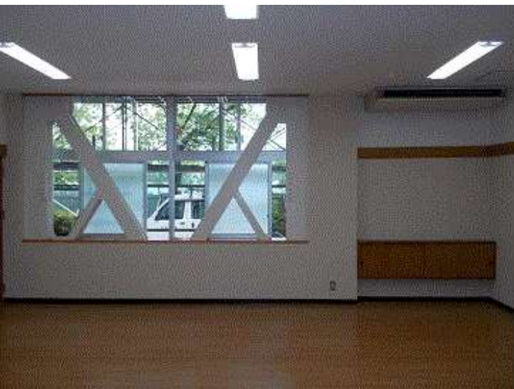
耐震化工事が完了した川之江北中学校南校舎
