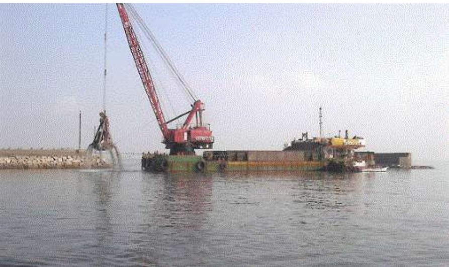
豊岡漁港浚渫(平成19年度)
