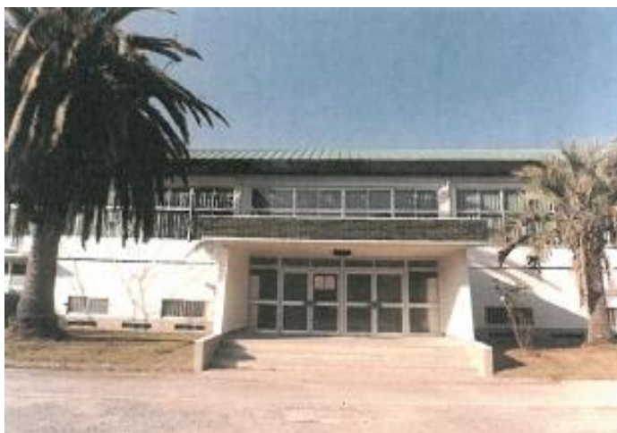
耐震化工事が完了した川之江北中学校屋内運動場
