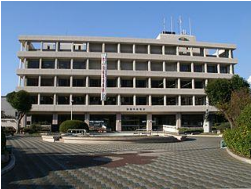
老朽化し、耐震性が不足している現在の本庁舎
