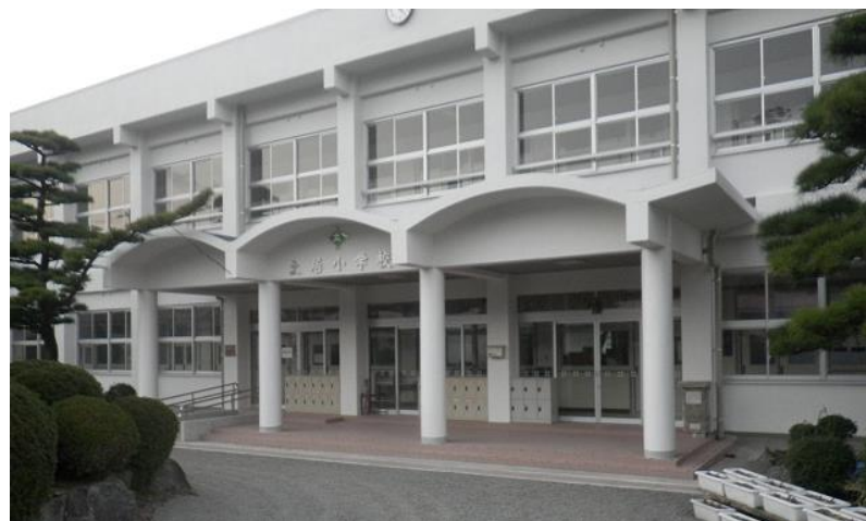
耐震化工事が完了した土居小学校南校舎
