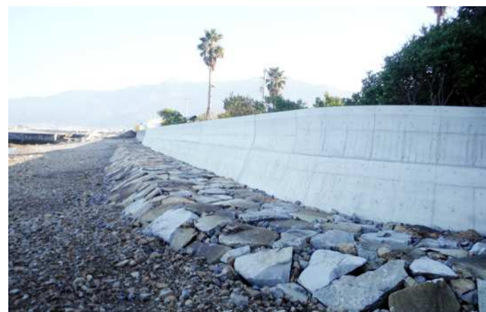
整備が完了した堤防（天満漁港）
