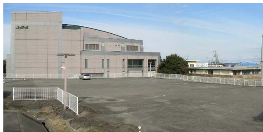
土居文化会館（ユーホール）
