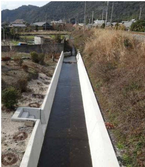
水路改良の様子 (土居町北野)
