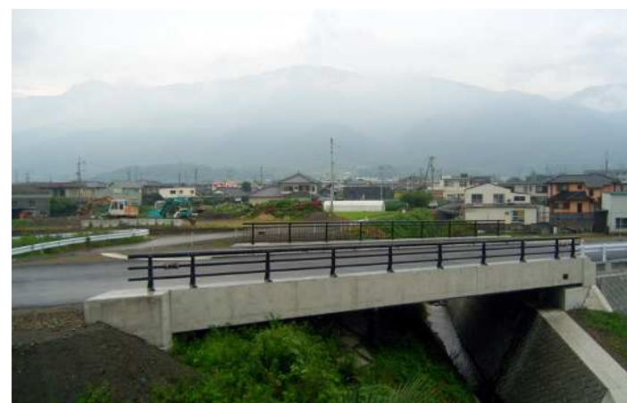
橋梁整備工事により完成した新平和橋（土居町中村）
