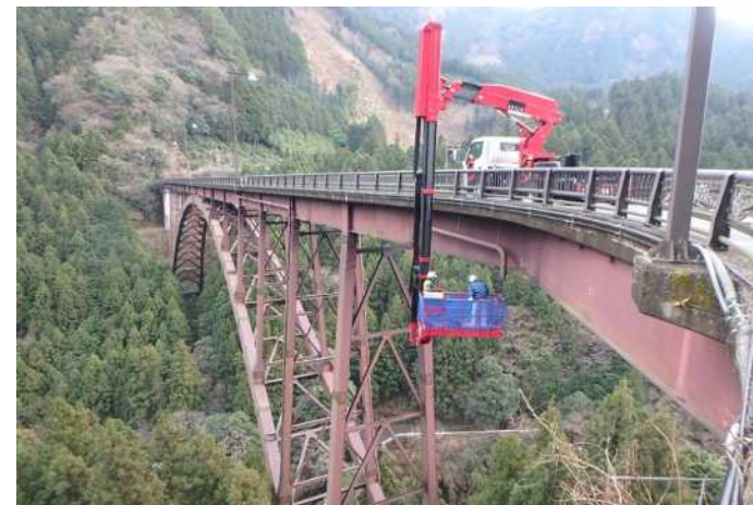
橋りょう点検の様子
