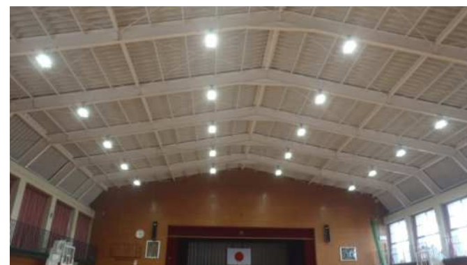
非構造部材（天井）を撤去し、照明もLED化された体育館（中之庄小学校）
