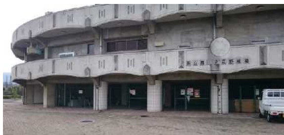
改修工事を予定している浜公園野球場
