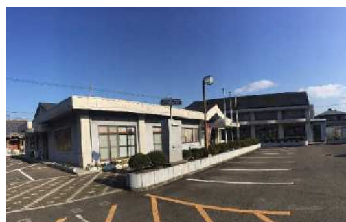
改修工事を予定している妻鳥公民館
