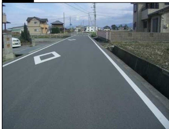
整備後 写真箇所
