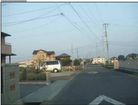
整備前 写真箇所
