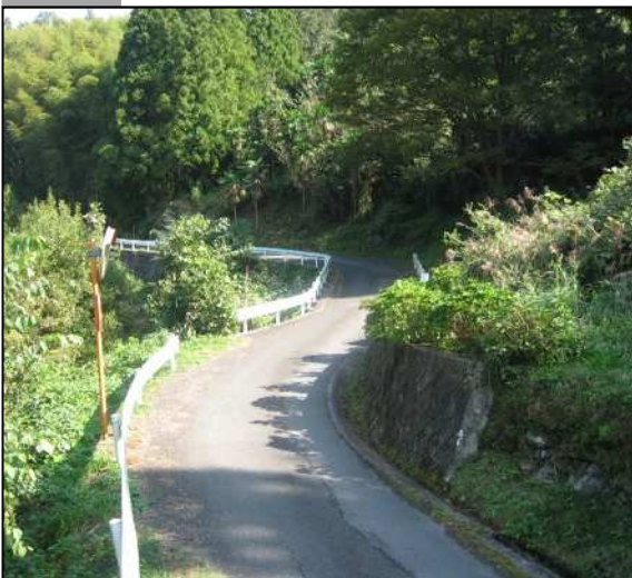
整備前 写真箇所
