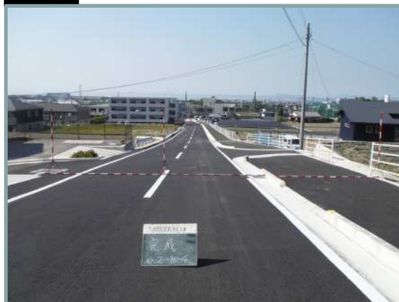
整備後 写真箇所 - 2
