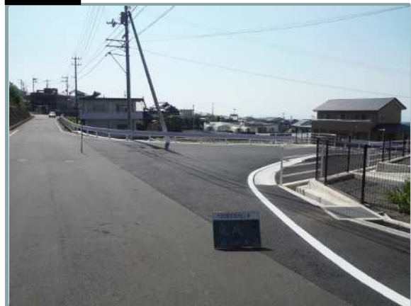
整備後 写真箇所 - 1
