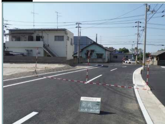
整備後 写真箇所 - 3
