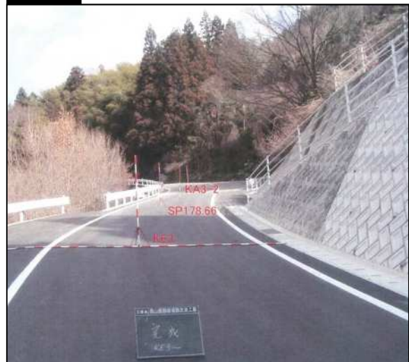
整備後 写真箇所
