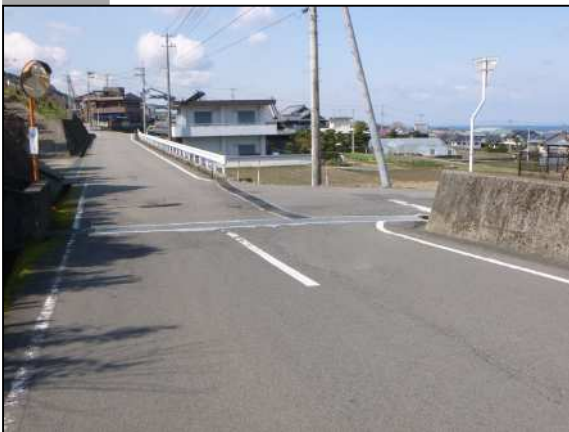
整備前 写真箇所 - 1
