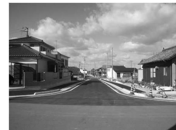
完成が近い江之元大通り線 (幅員10m)
