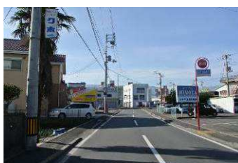
歩道の路面が老朽化 (市道駅通栄町線)
