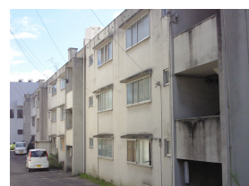
④港通り市営アパート
