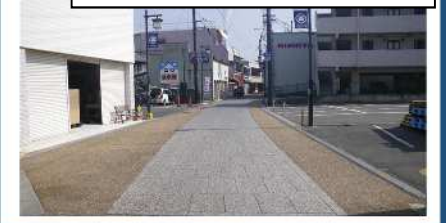
カラー舗装・バリアフリー化等
