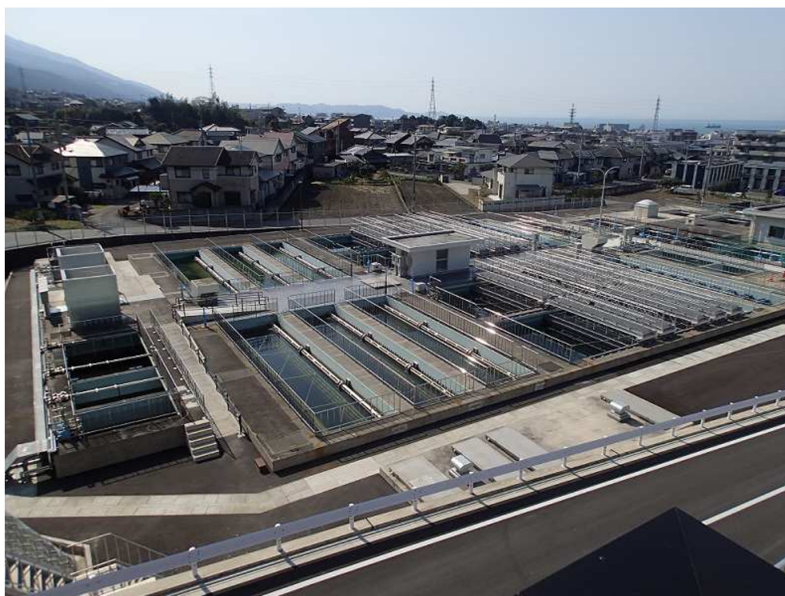
【中田井浄水場 浄水処理施設】
