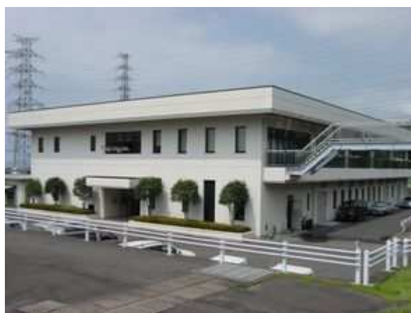
【中田井浄水場 管理本館】
