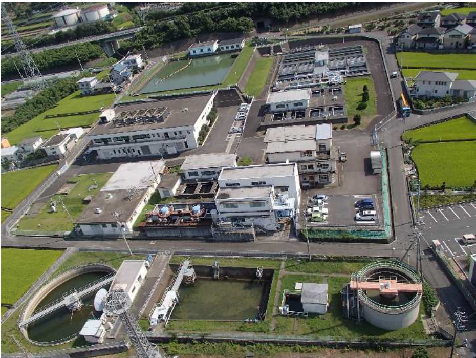
浄水場 全景 (北方向より)
