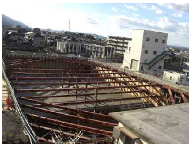
中田井浄水場 更新工事中写真(平成 29 年 12 月)
