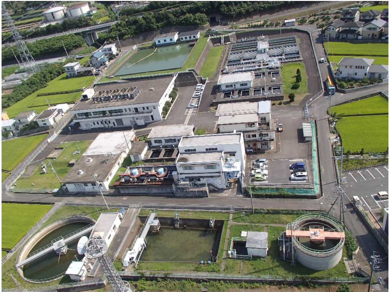
浄水場 全景 (北側より) (「中田井浄水場等更新整備・運営事業」開始前)
