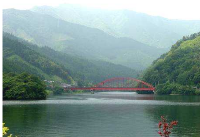
金砂湖畔公園より (西方向)
