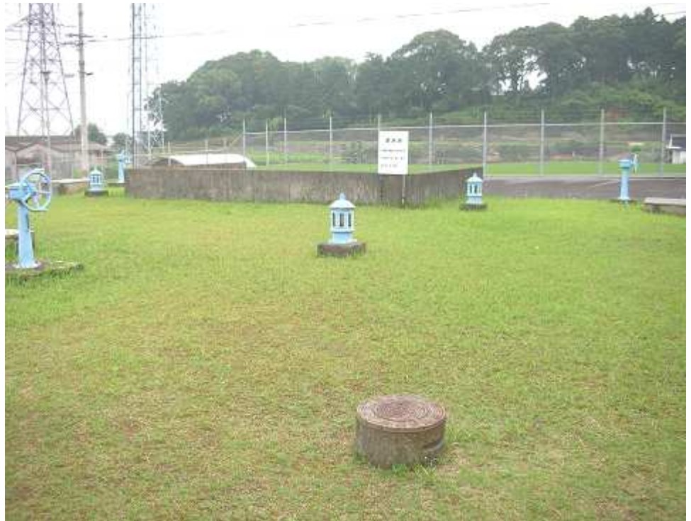
浄水池 (地下) (更新前)
