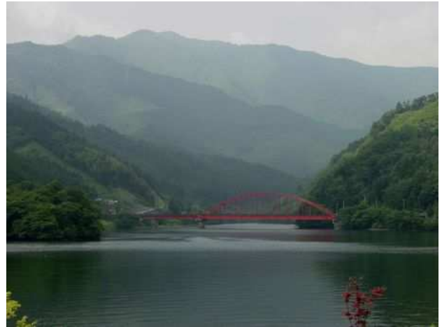
柳瀬ダム(平野橋より)
