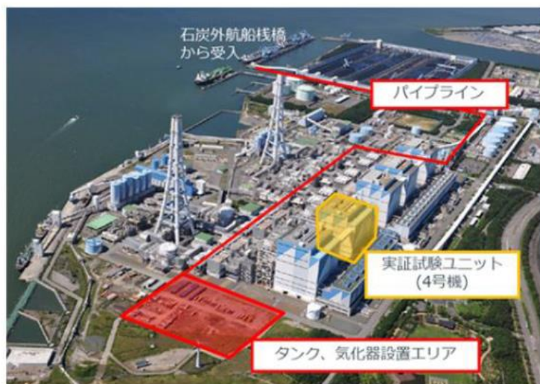
参考1: 実証事業を行う碧南火力発電所（愛知県碧南市）
