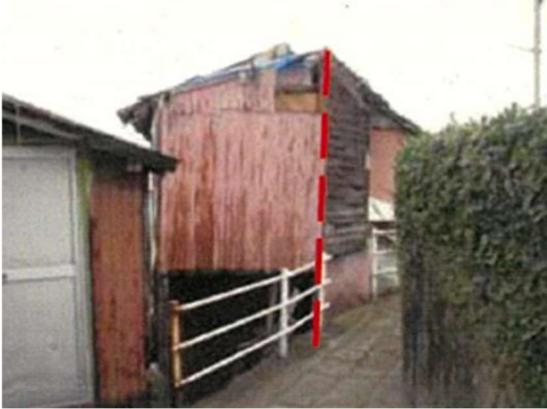
一部の柱が傾斜している例
