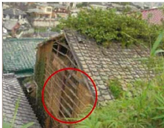
外壁が剥落し、著しく下地が露出するとともに、壁体を貫通する穴を生じている例
