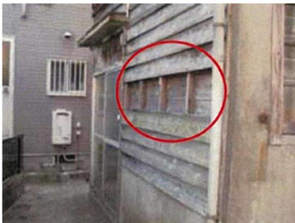
外壁の仕上材の一部がはがれ、下地が露出している例
